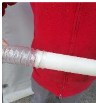
11 Koppel de flexibele slang aan de starre buis.
